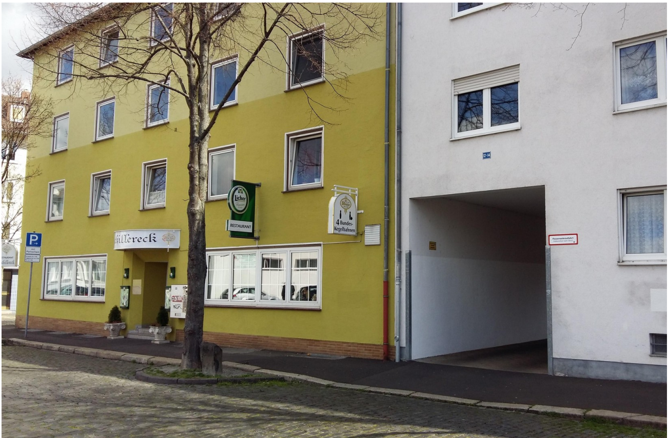
Vorderseite Haus Einfahrt
