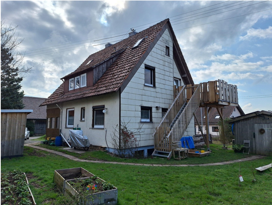
Aussenansicht von Westen
