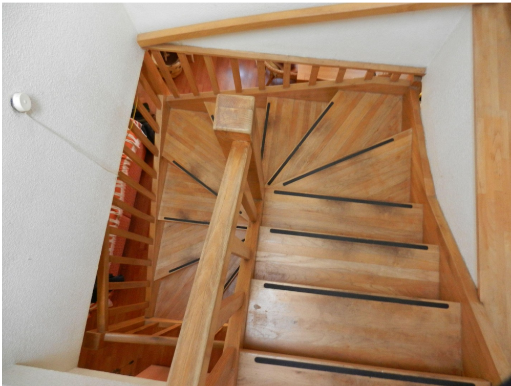
Treppe vom 4. ins 5. OG
