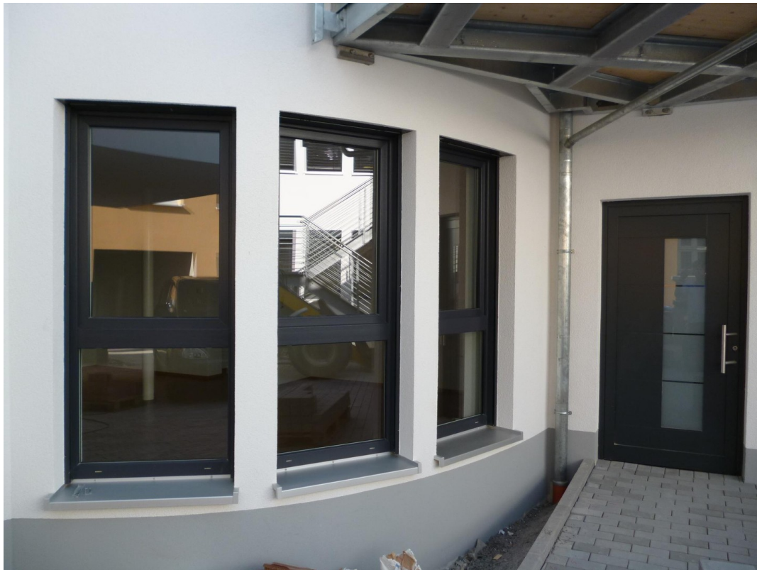
Wohnung außen und Eingang
