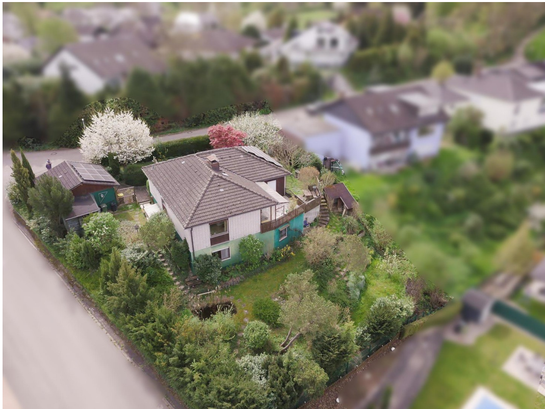
Blick von Nordwest
