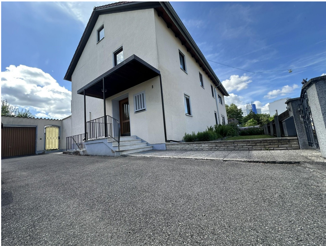
Hausansicht von der Straße
