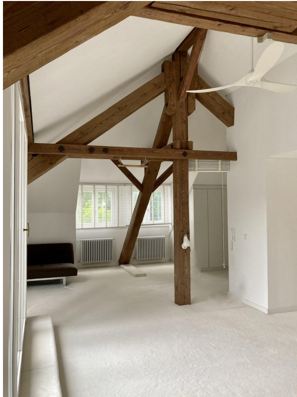
Dachbalken im Dachgeschoss
