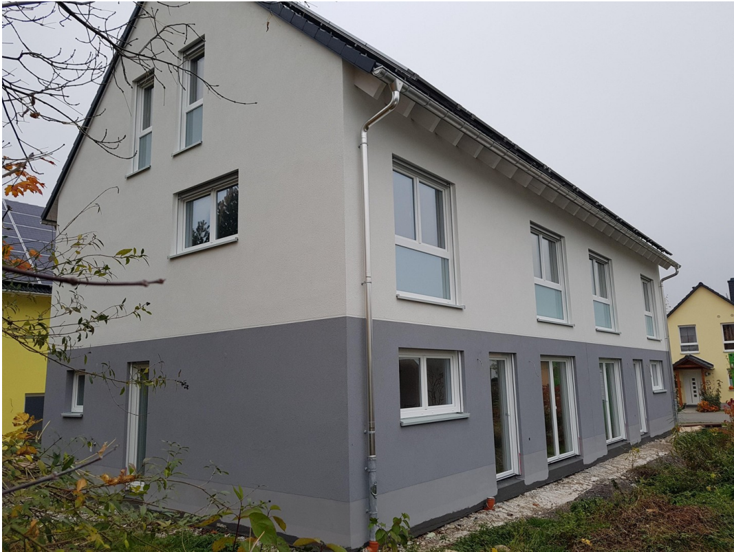
Foto Bauzeit vor Bau Terrasse
