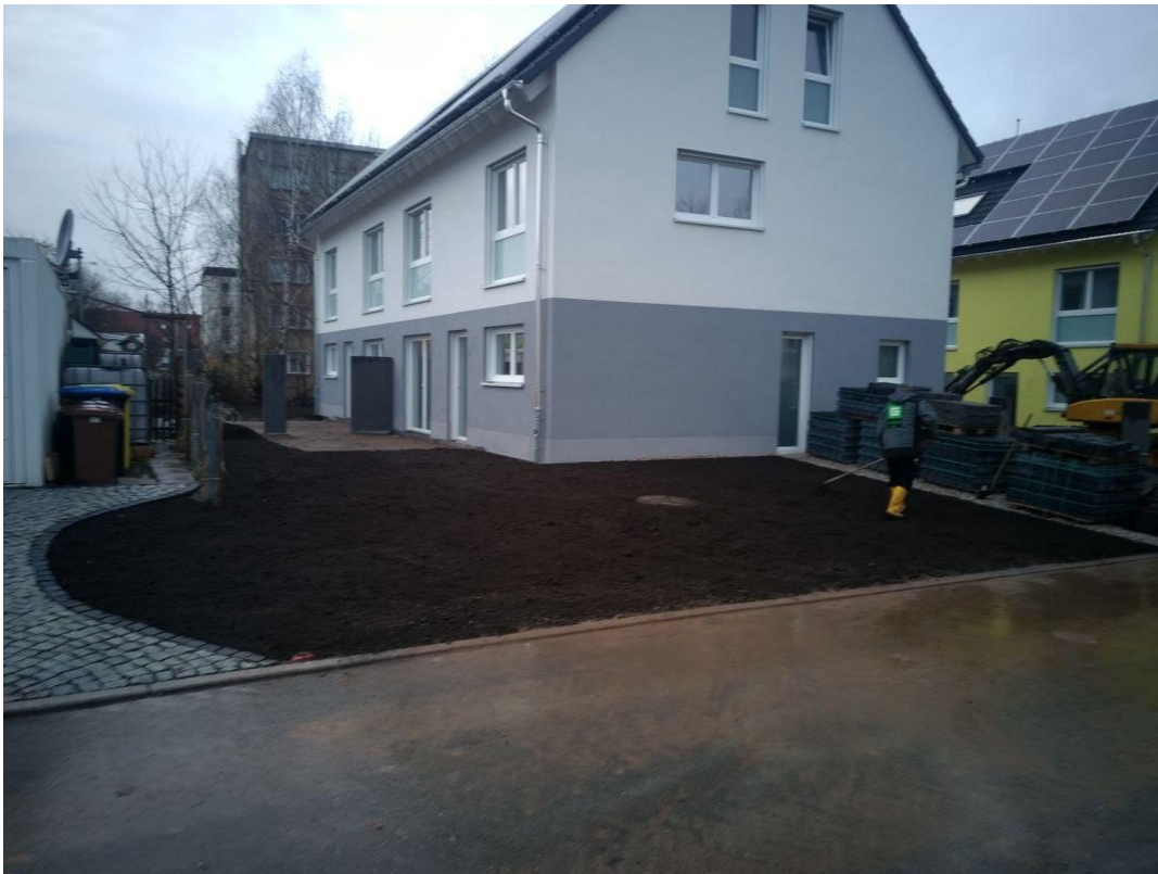
Foto Bauzeit vor Bau Terrasse
