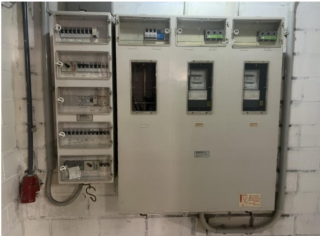
Stromverteilerkasten
