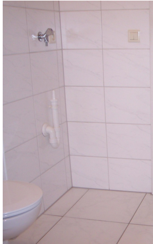
Bad Waschmaschinenanschluß
