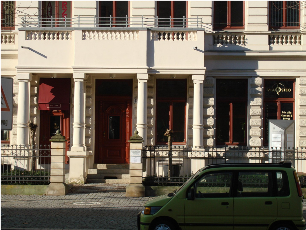
Zugang zum Haus
