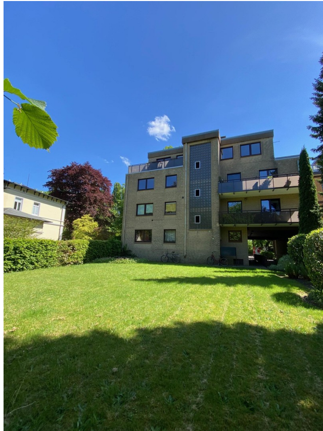
Gebäude hinten + Garten
