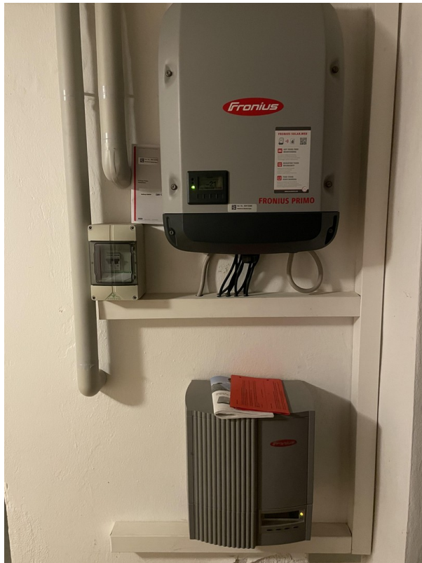
Wechselrichter Solar KG
