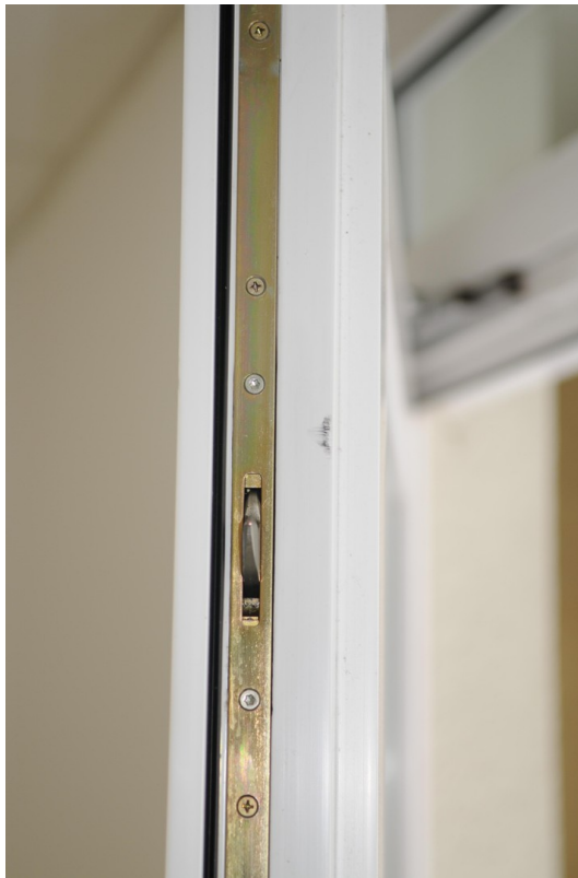
3 Riegel sichern Ladentür
