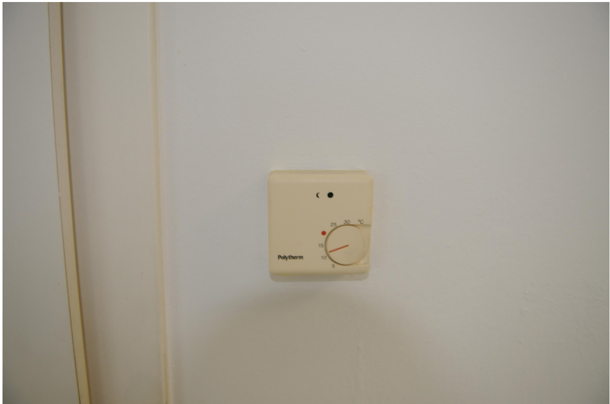
Thermostat Fußbodenheizung
