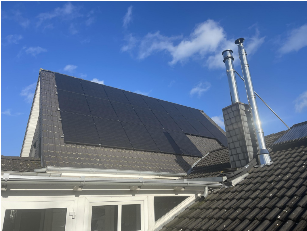
PV Anlage 10 KW
