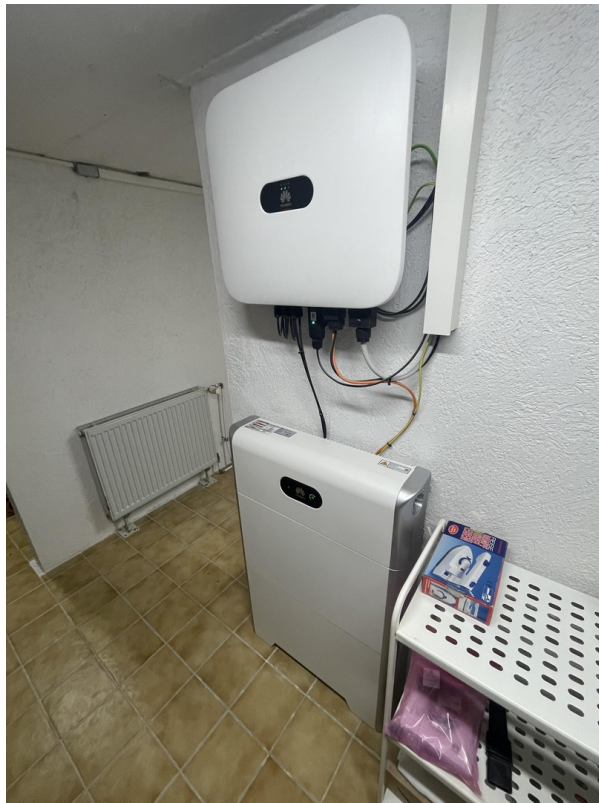
Batteriespeicher PV 10 KW
