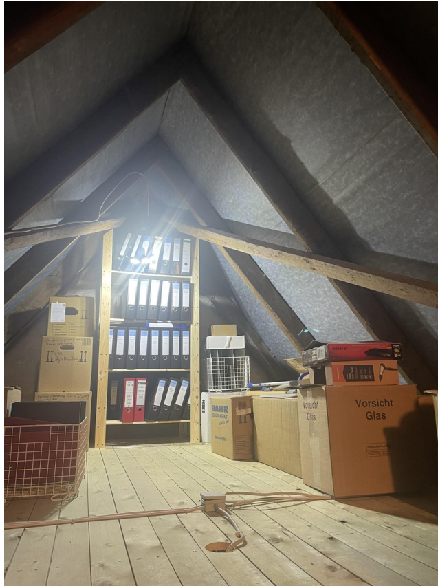
trockener Boden gedämmt
