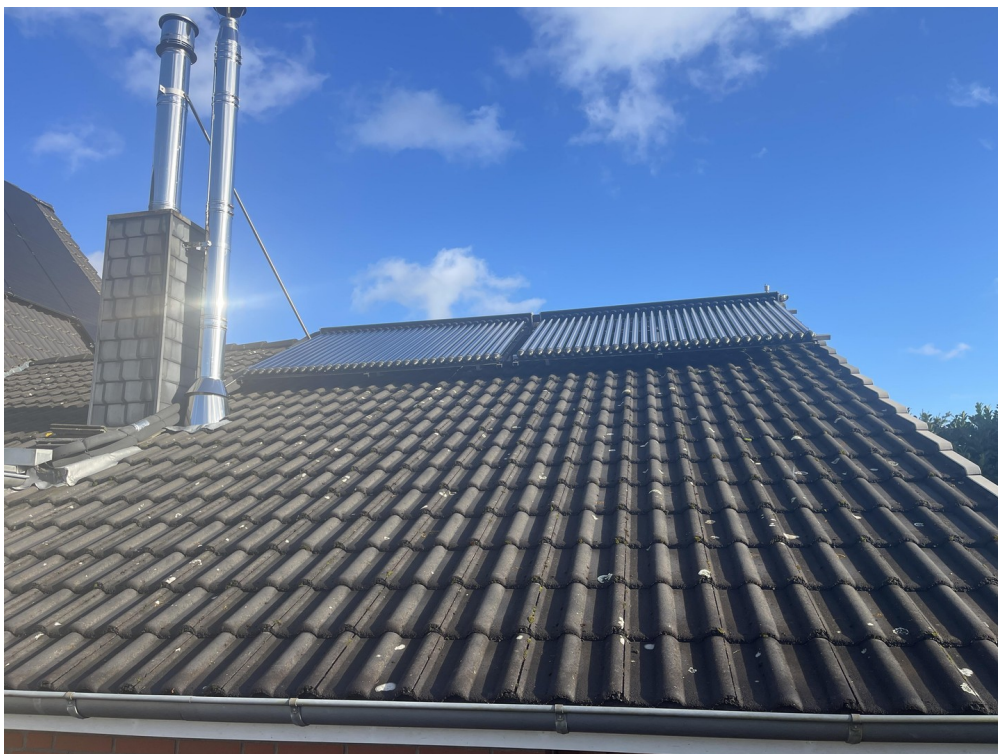
Solarthermieanlage
