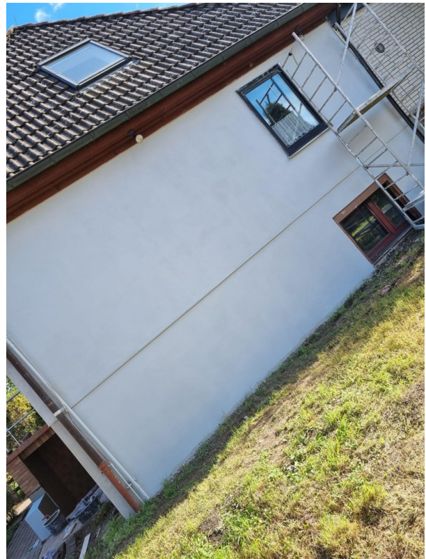
Fassade neu verputzt
