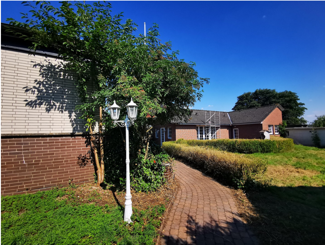
Ansicht mit Hinterhaus
