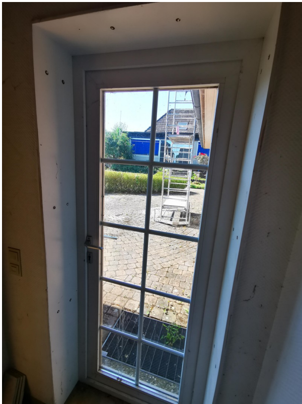
Blick Terrasse Hinterhaus
