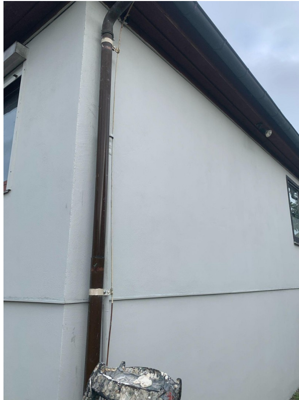
Fassade neu verputzt
