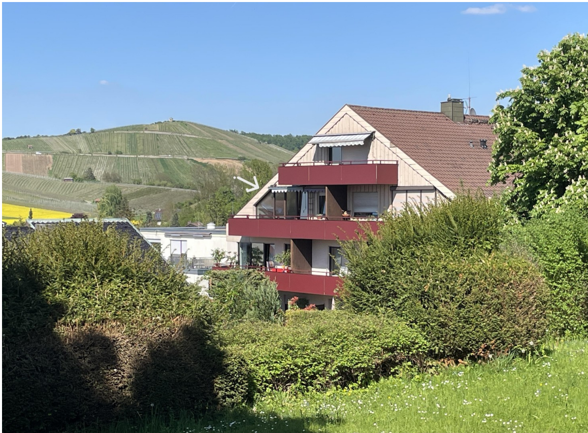
Blick von Südwest
