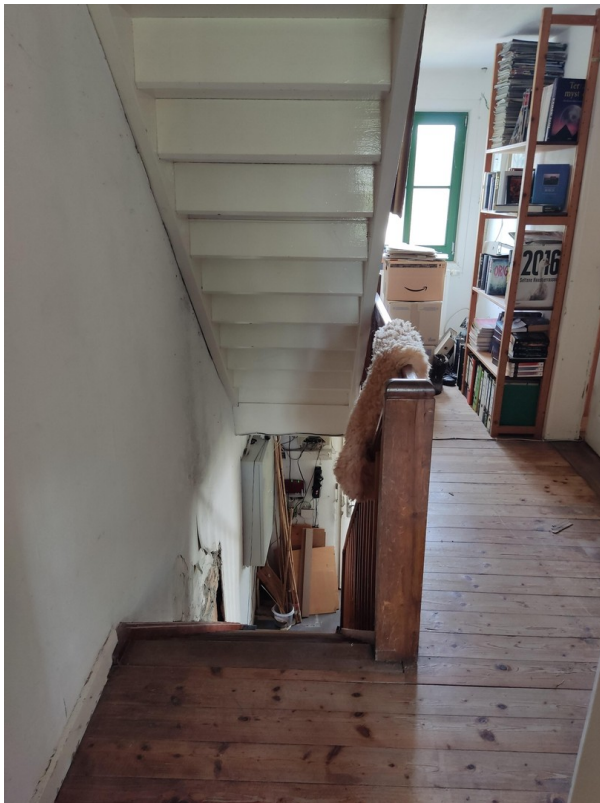
Treppenhaus im Altbau
