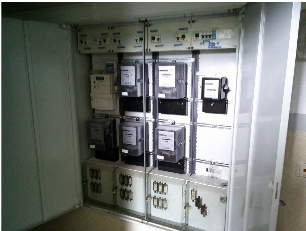
Zentrale Zähleranlage
