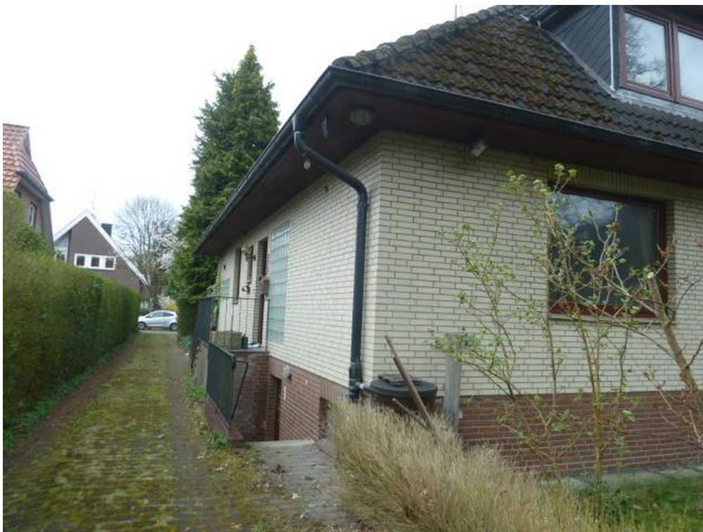
Eingangsbereich von hinten
