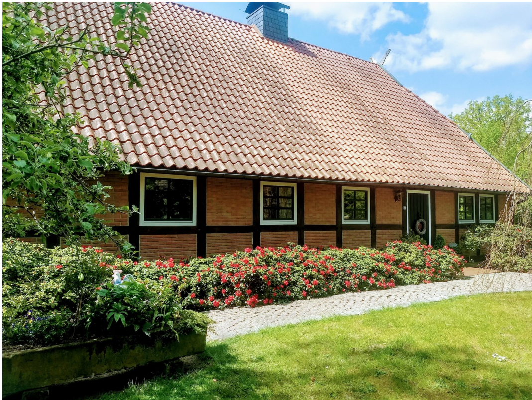
Haus zur Strassenseite
