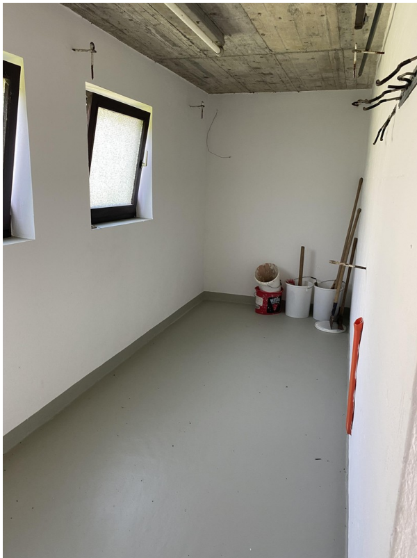
Geräteraum hinter Garage
