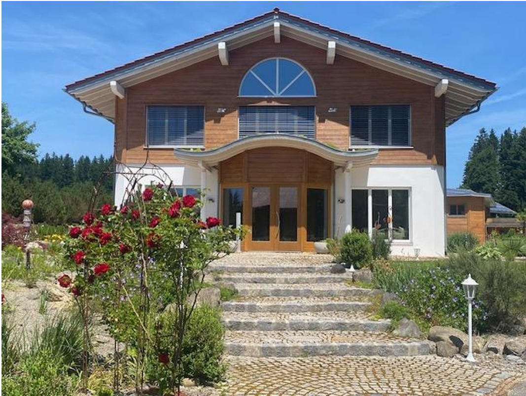
Aussenansicht mit Treppe Süd
