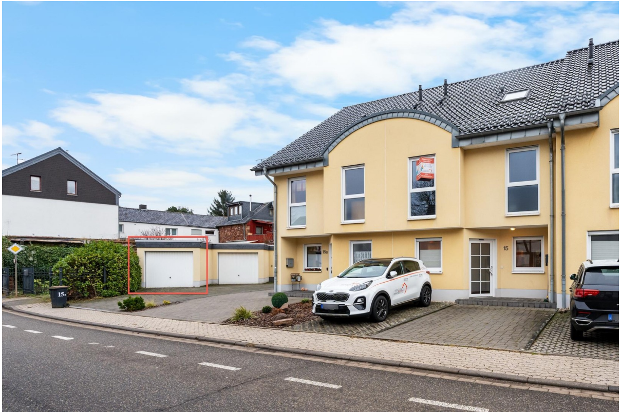
Eingangsbereich mit Garage
