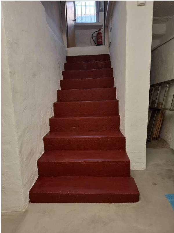
Treppe in Keller
