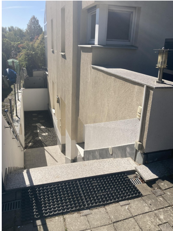
Eingangsbereich im Sousterrain
