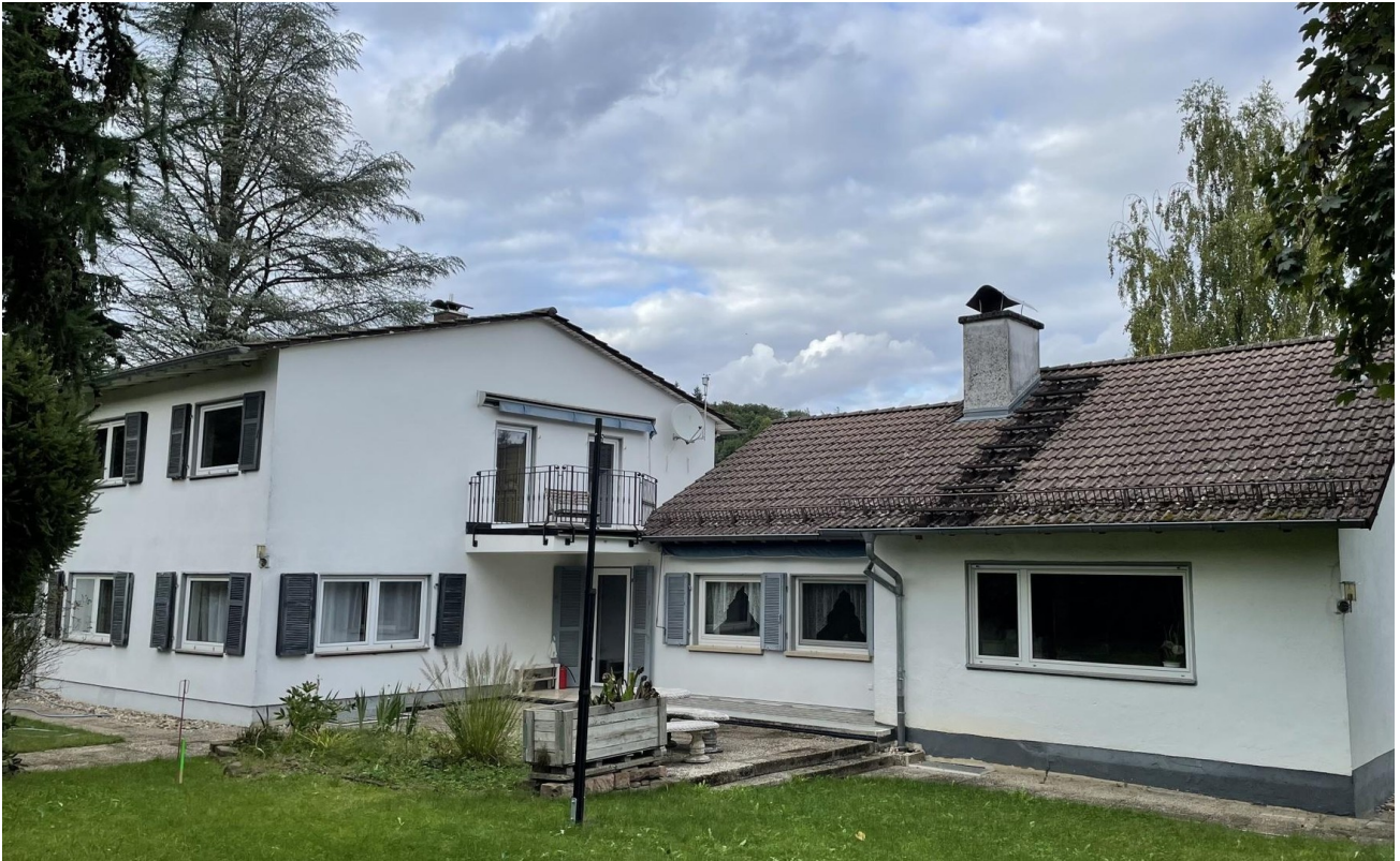
Ansicht von Süden mit Terasse
