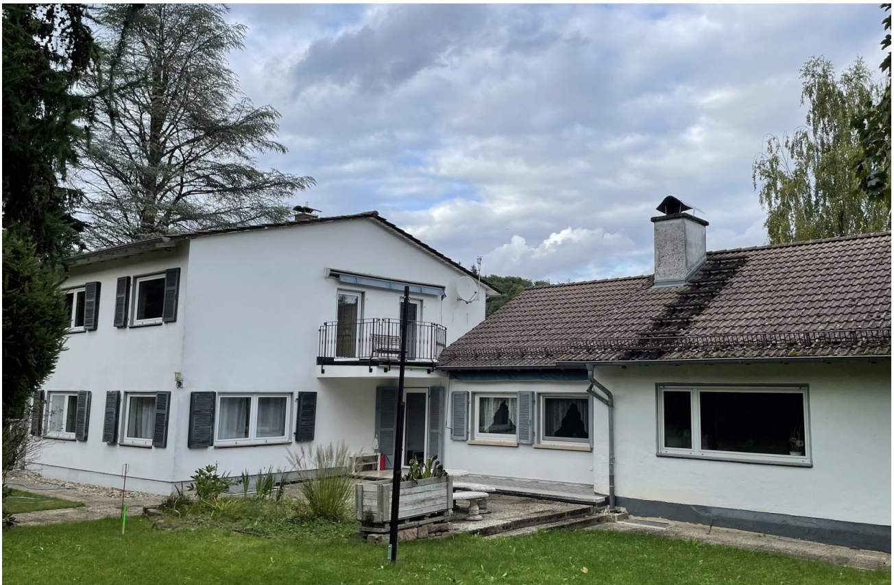
Ansicht von Süden mit Terasse
