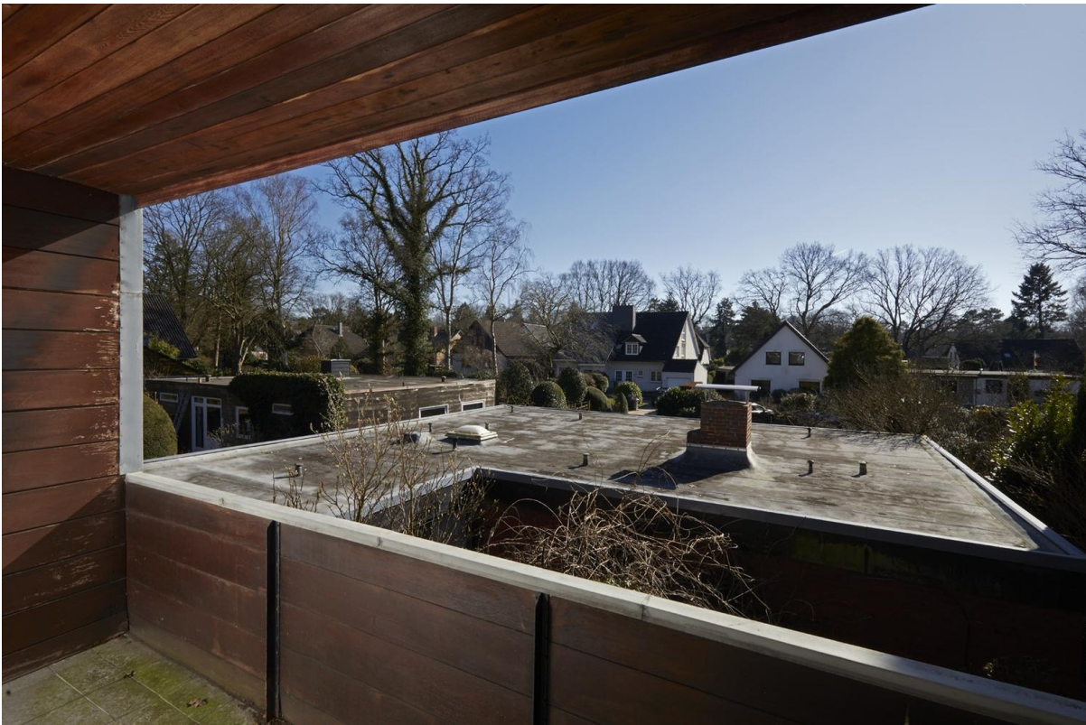
Loggia Blick nach Süden
