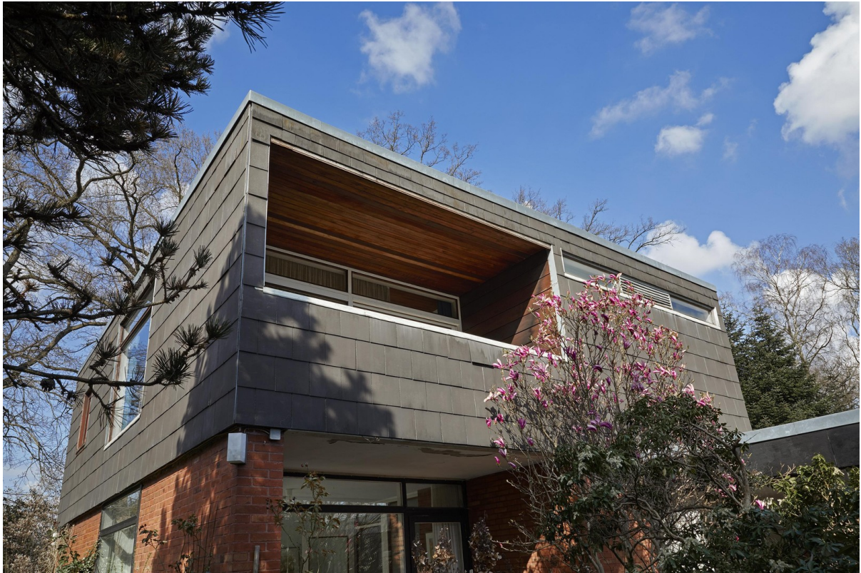
Blick aus Atrium
