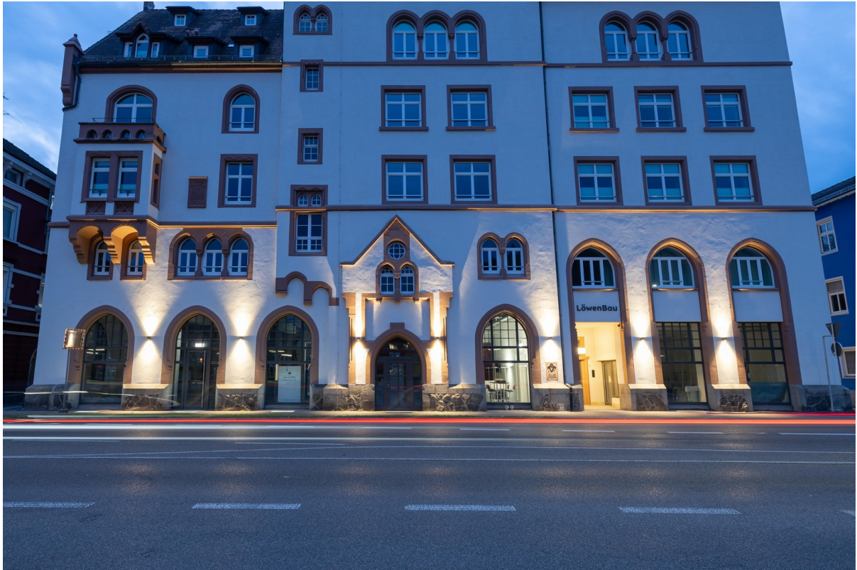
Ansicht Fassade Dämmerung
