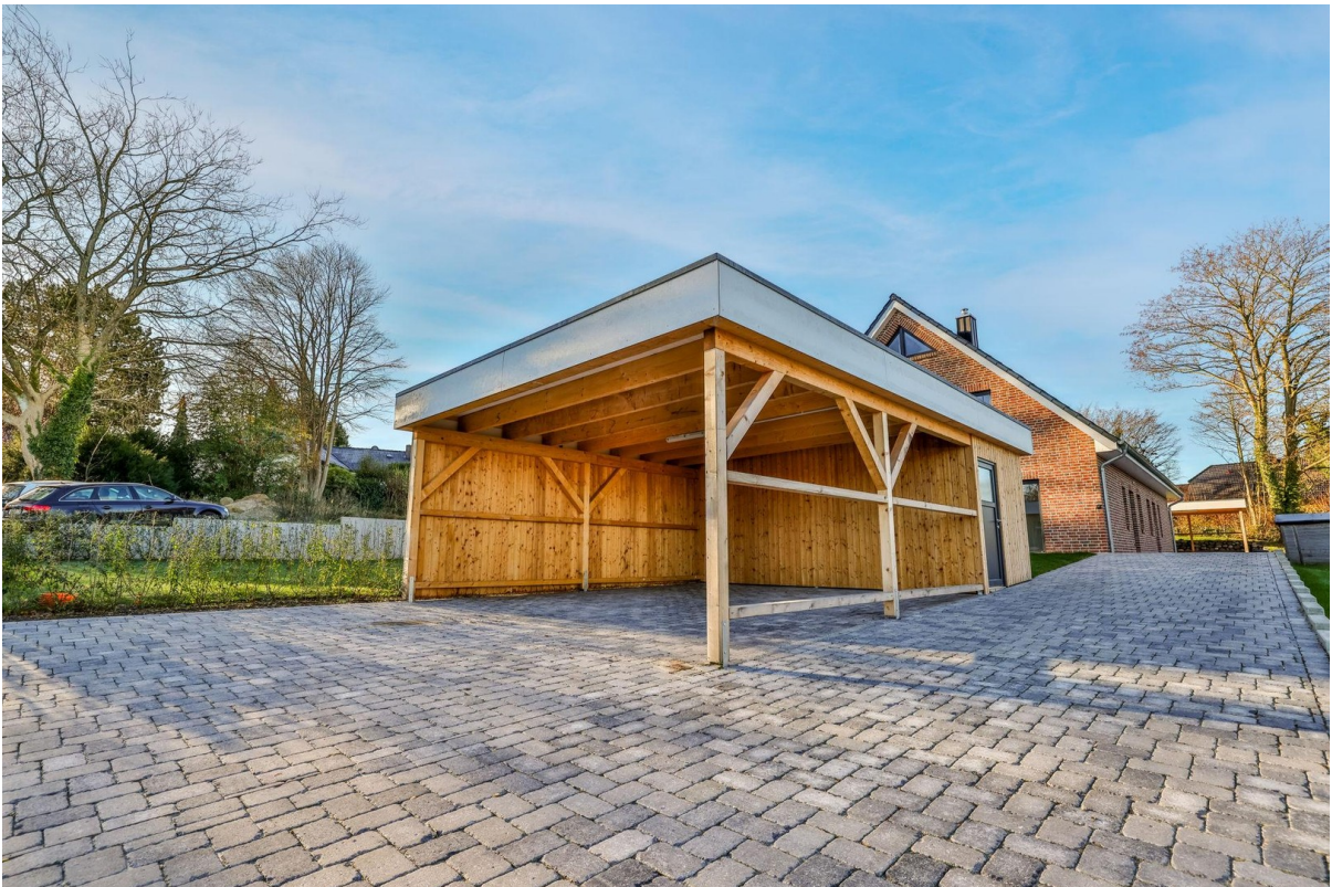
Carport vorderes Haus
