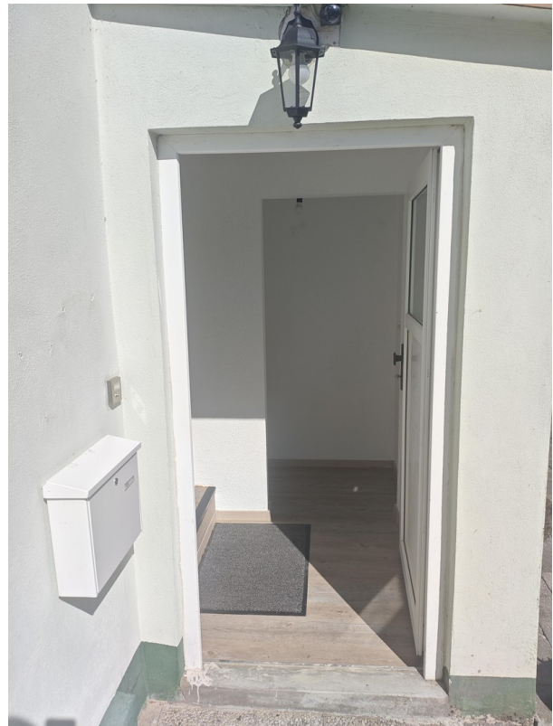
Eingang (von Außen)
