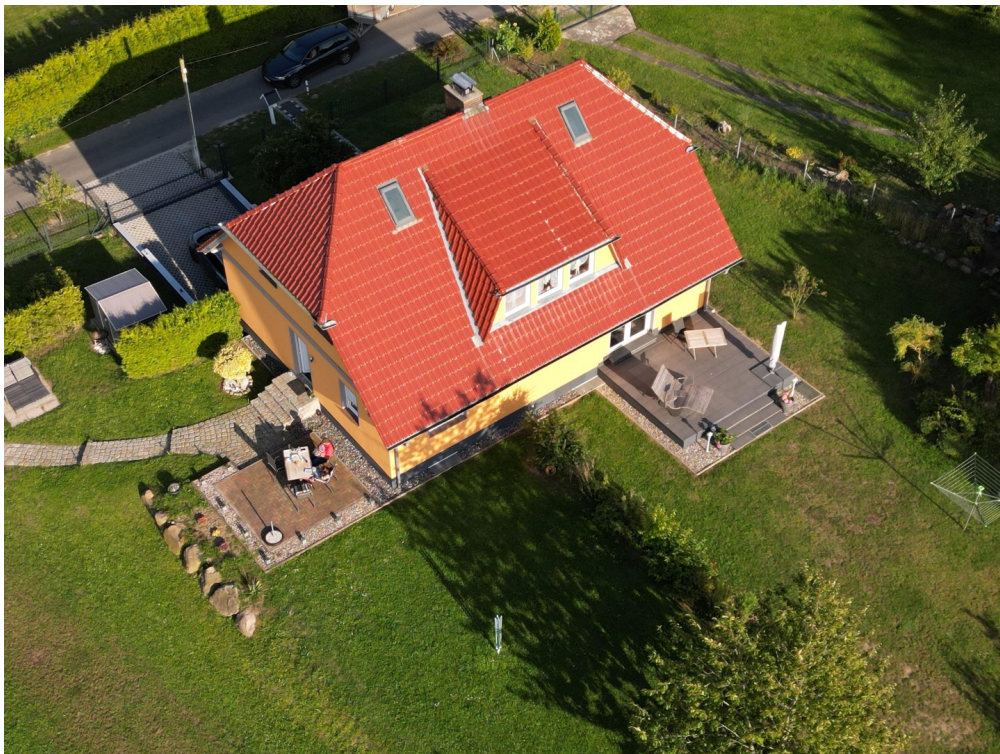
Luftaufnahme der Immobilie
