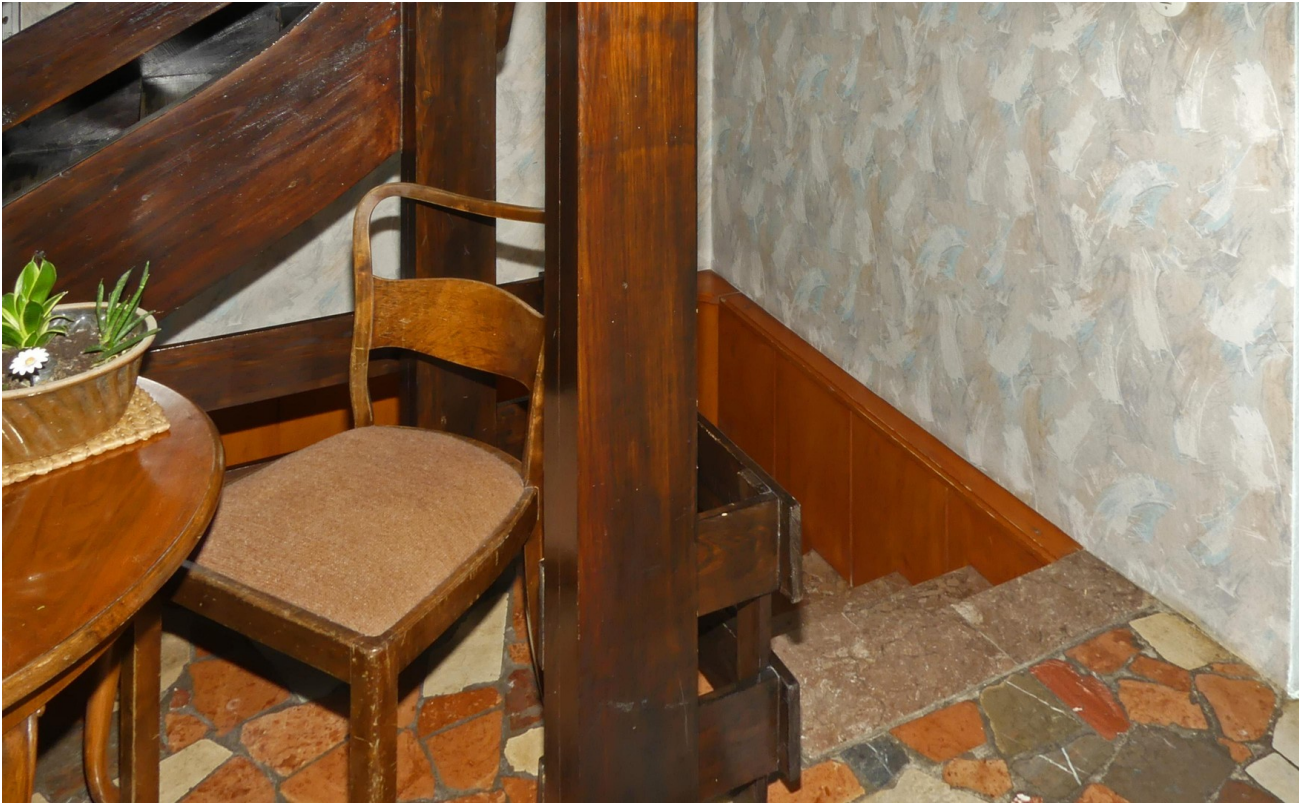
EG Diele / Kellertreppe
