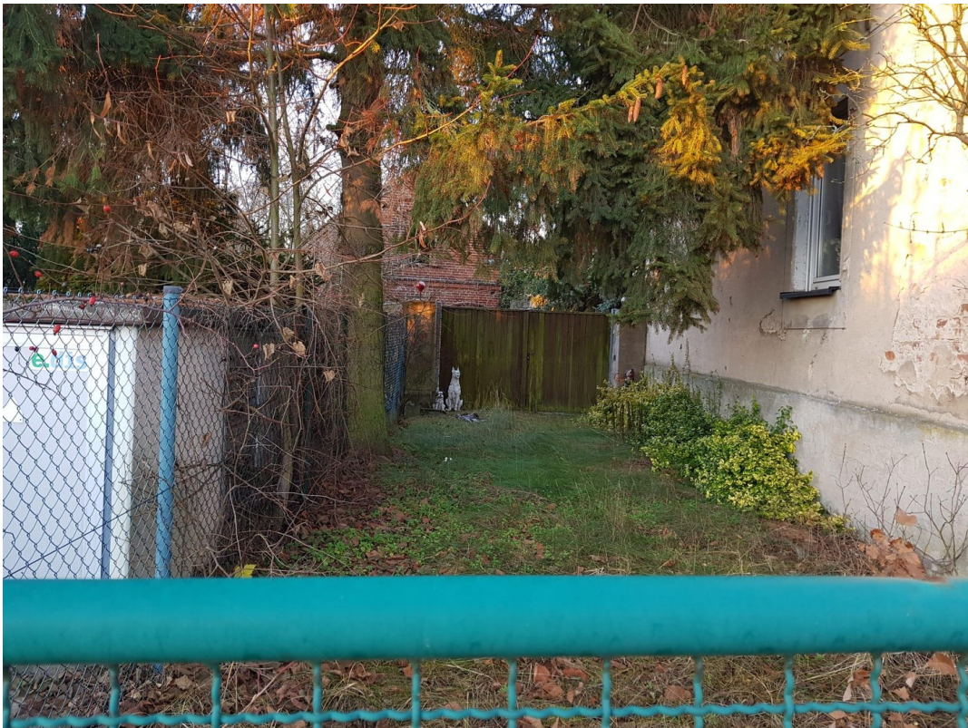
Trafo links der Einfahrt
