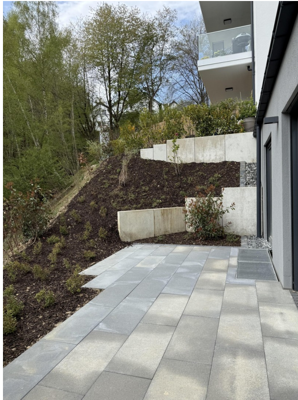
Terrasse Blick Richtung Westen
