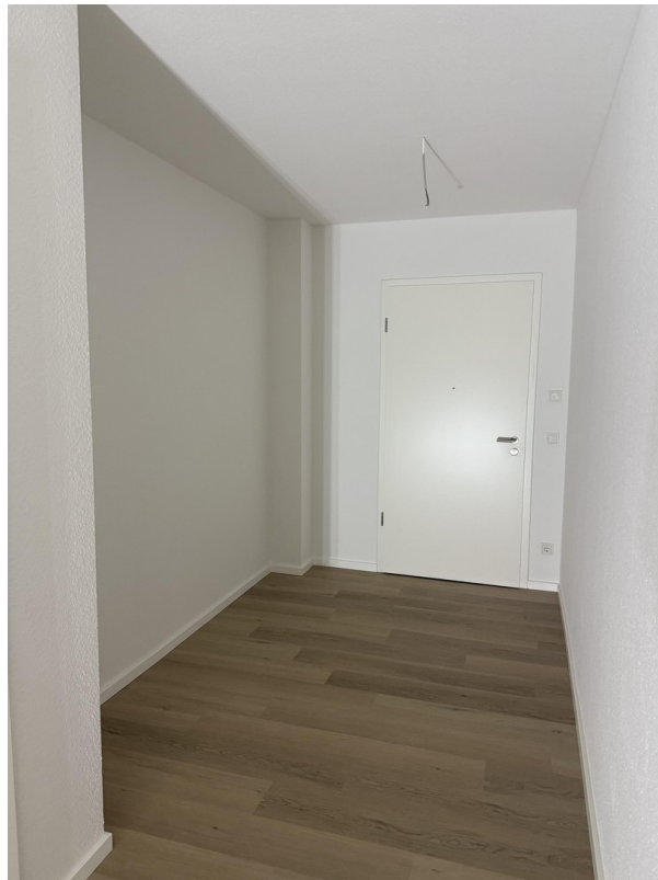
Flur Blick zur Haustür
