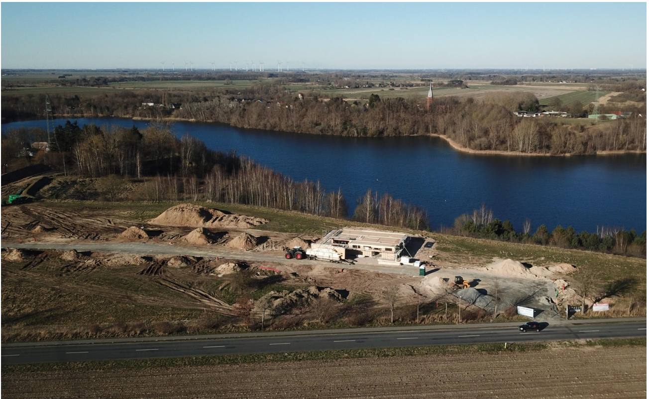
Erstes Haus wird errichtet
