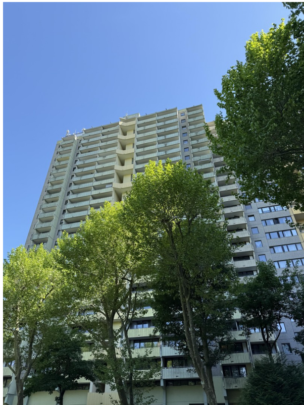
Blick auf die Hausanlage
