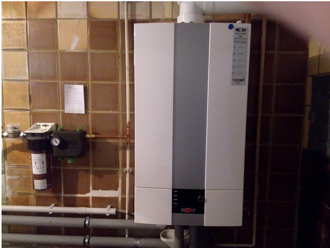
UG Gas-Brennwertheizung
