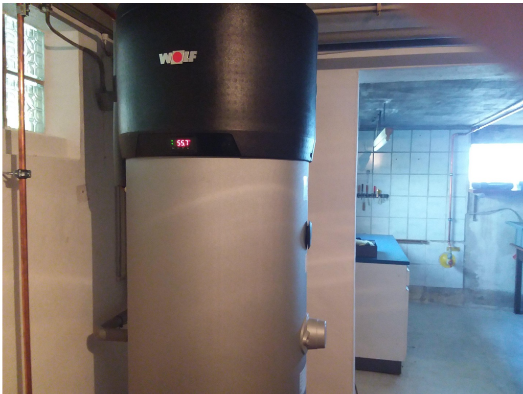
UG Brauchwasser-Wärmepumpe
