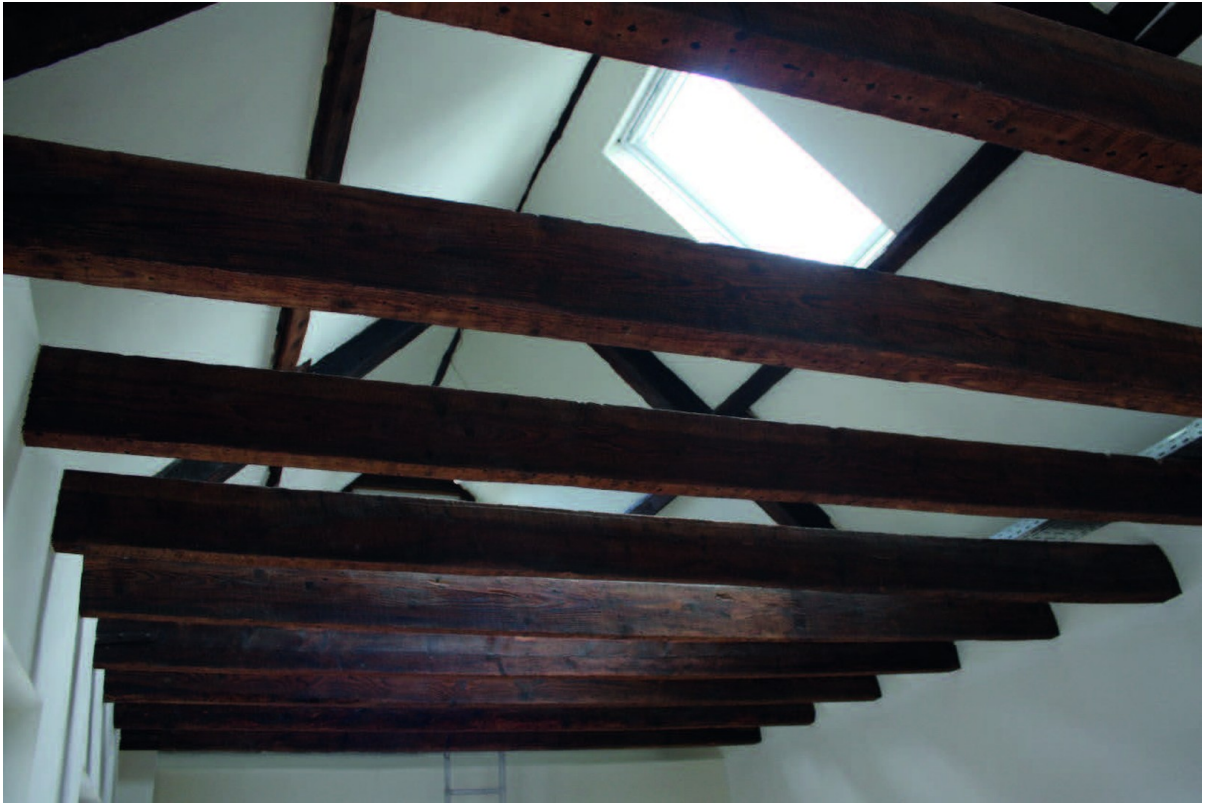
Giebel mit Dachfenstern
