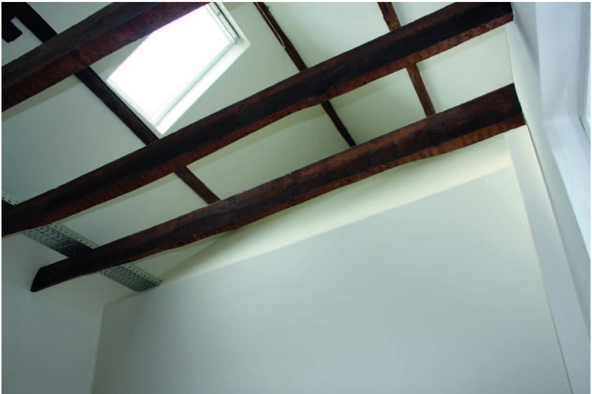
Giebel mit Dachfenstern
