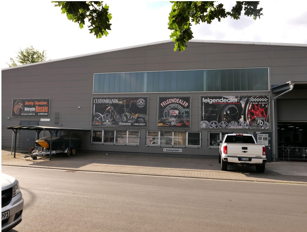
Frontseite des Objekts
