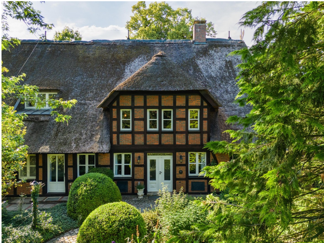
Erker mit Hauseingang
