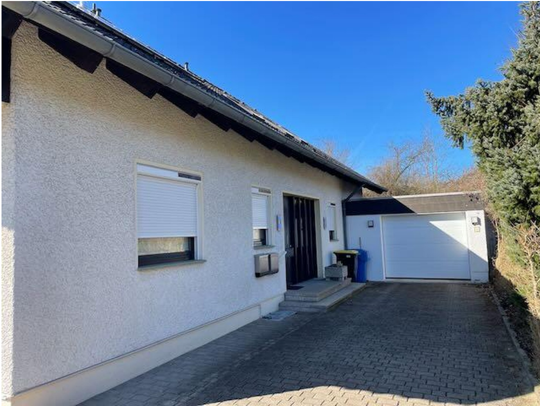
Einfahrt mit Garage
