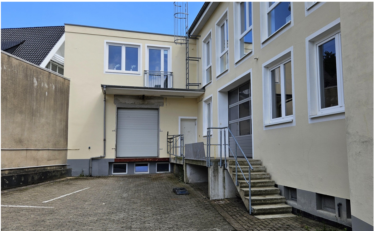
Rampe Rückseite Gebäude
