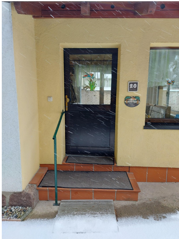
Hauseingang (neue Haustür)
