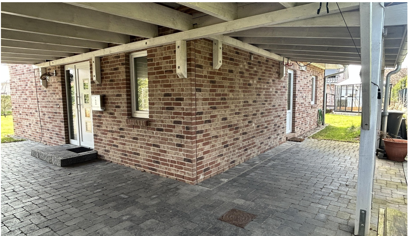
Carport geht bis hinters Haus
