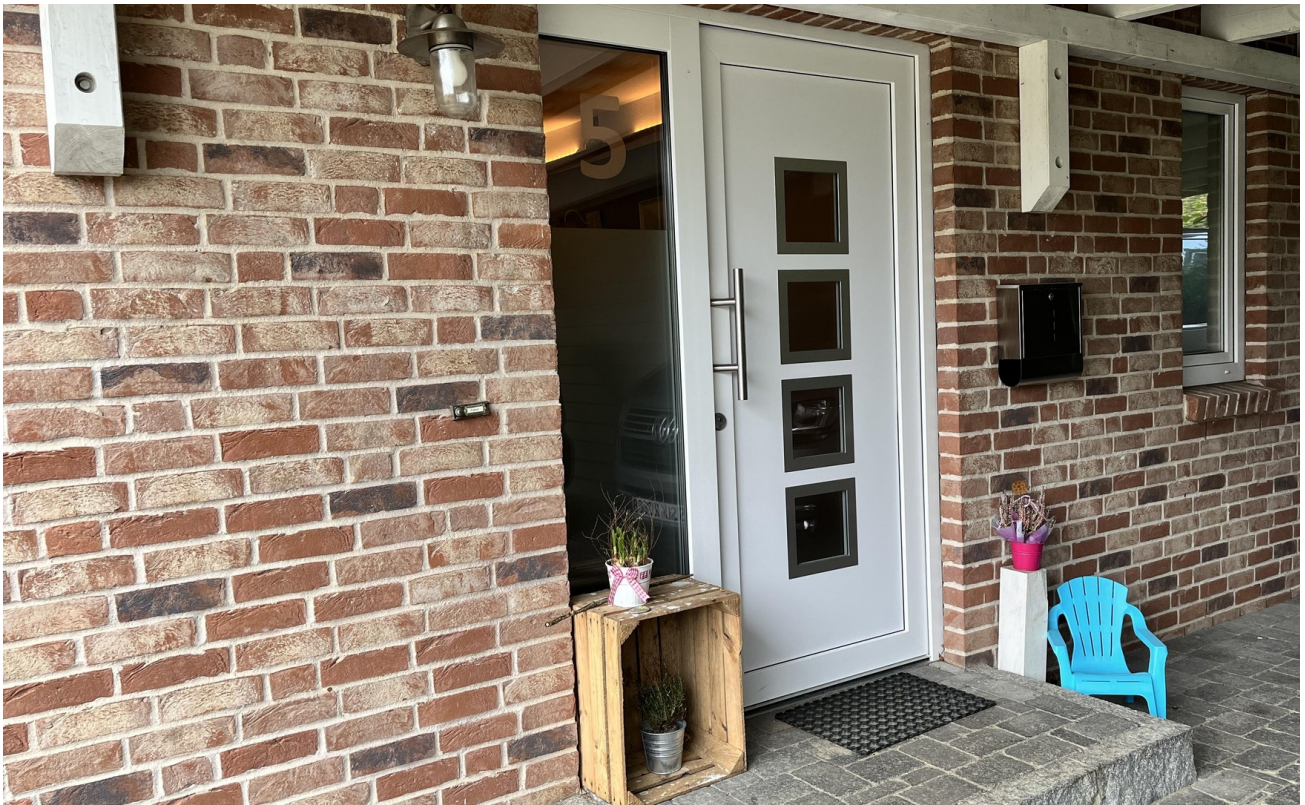
Haustür unter Carport
