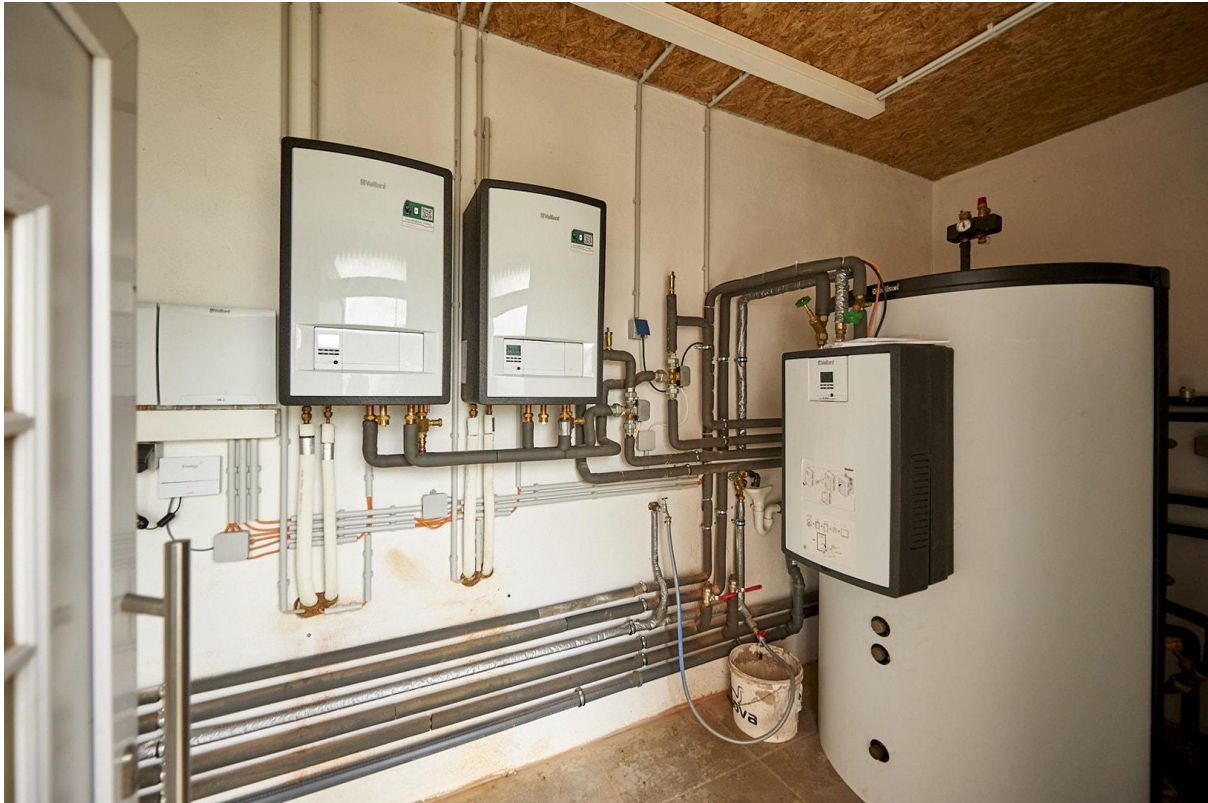
Heizungsanlage Luft-Wärmepumpe
