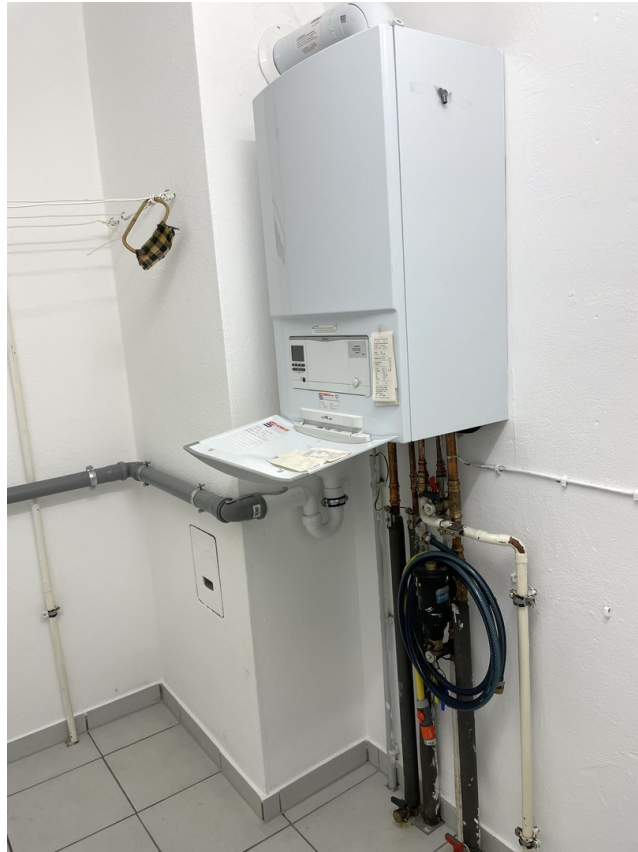
HWR 5,06 m 2 mit Brennwerttherme
