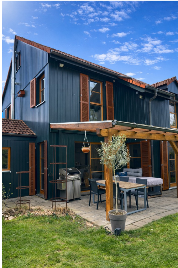
Überdachte Terasse & Schuppen
