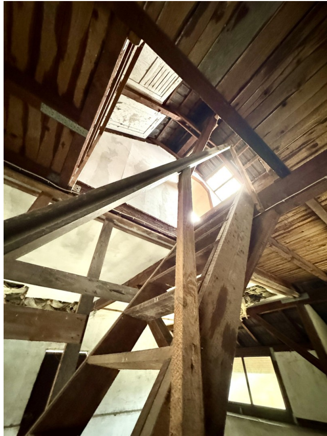
Lagegebäude - Blick in DG
