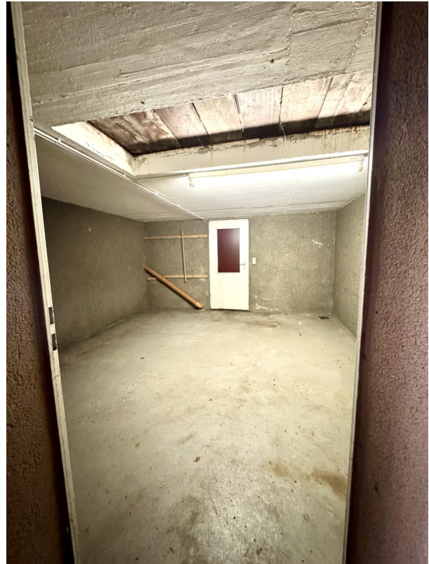
Garage - Raum unter Grube
