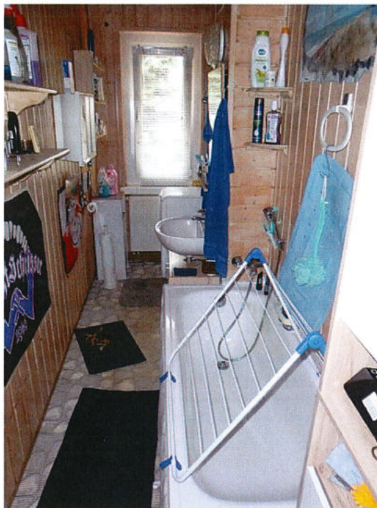
Gartenstraße unrenoviert, Königshain-Wiederau - Bild 4
